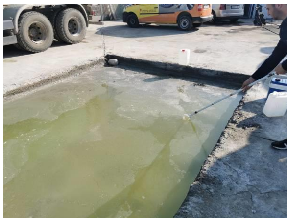
Slika 4. Taložnik suspendovanih materija
